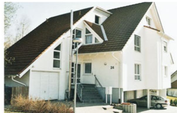
Ins Haus integrierte Garage mit Schleppdach
